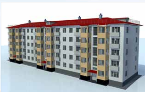
Рис. 6 Здание с надстройкой эркеров вдоль здания
