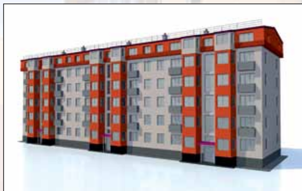
Рис. 7 Здания с созданием эркерной системы и мансардного этажа
