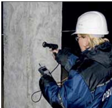
Определение прочности бетона монолитных ж/б колонн методом ударного импульса на стройплощадке.
